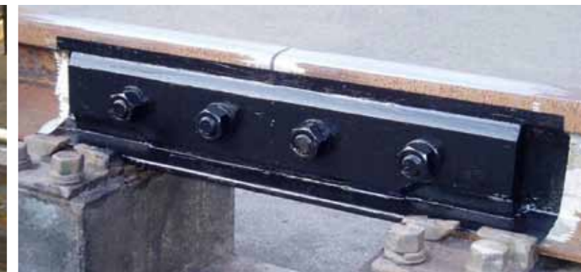
Isolierstoß ETW 1 Insulated rail joint ETW 1 Joint isolant ETW 1
