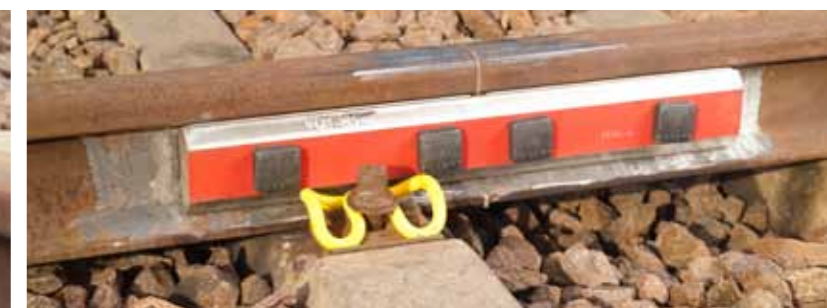
MT-Stoß für die temporäre Verwendung auf Baustellen MT-joint for the temporary use on sites Joint isolant MT pour une utilisation temporaire sur les chantiers de construction
